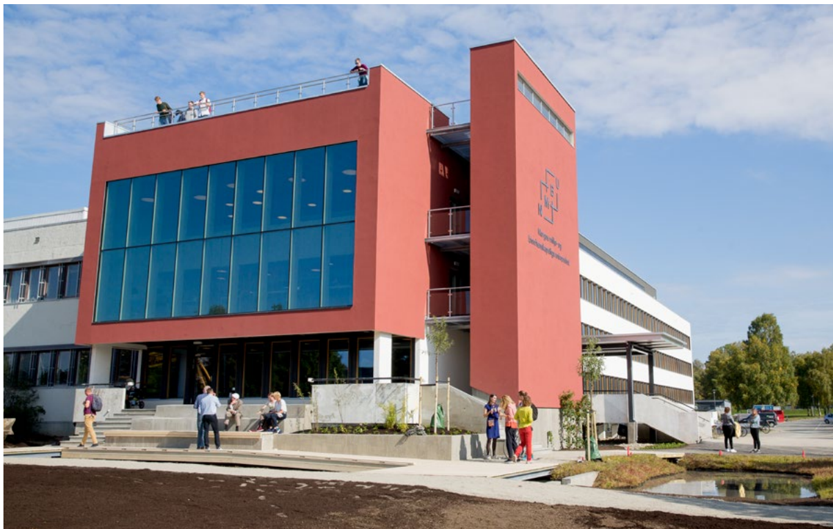
Eit staseleg TF-bygg etter restaurering. Foto: Kai Tilley
