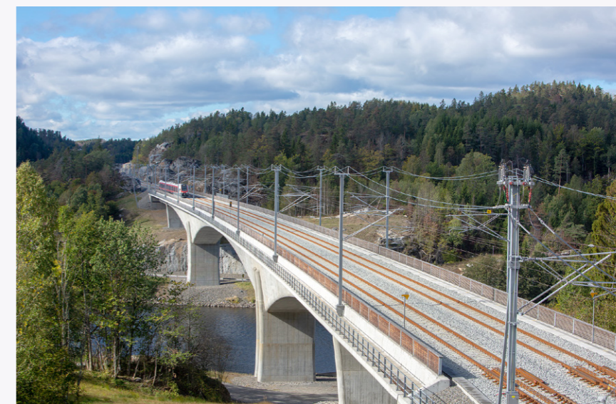
Hallevatnetbrua, utanfor Larvik, er 424 meter lang og er den lengste av ti bruer som er bygd mellom Larvik og Porsgrunn.
