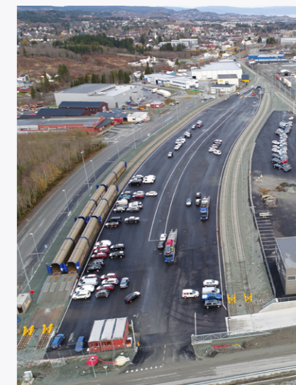
Trondheim godsterminal Heggstadmoen er ein føresetnad for å kunne få meir gods frå veg til bane.
