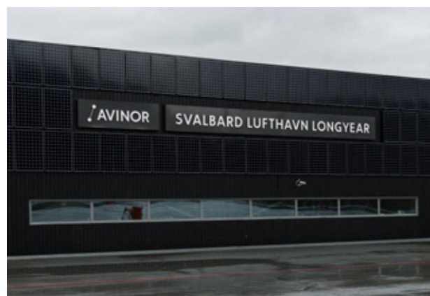
Solcelleanlegget på Svalbard lufthavn.
