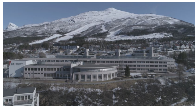
UiTs campus i Narvik gjennomgår en omfattende oppgradering som også sikrer et mer riktig klimaavtrykk på rundt 26 000 kvm bygningsmasse. (Foto: Screen Media)
