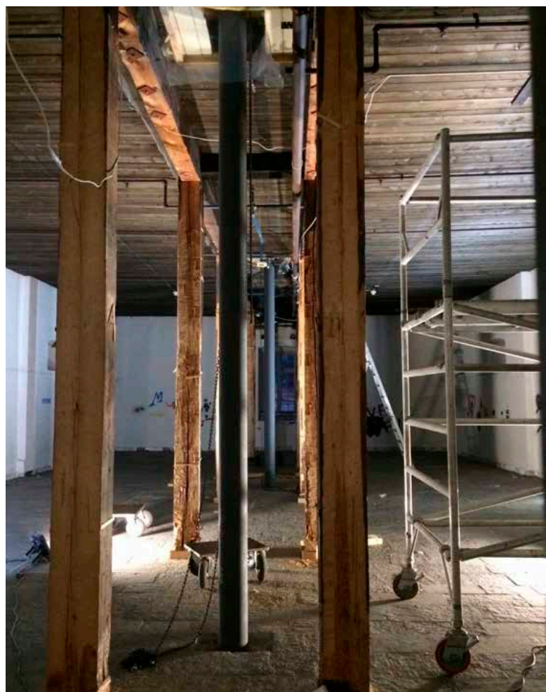
Omfattende ombygging i slighuset for å gjøre plass til Geolab.
