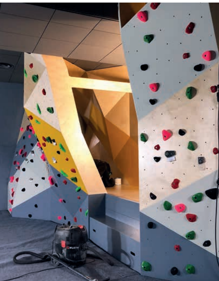
Buldrevgg med norske bergarter under oppføring i Geolaben.
