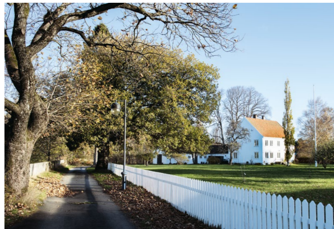
Oddernes prestebolig, i Kristiansand, er en av OVFs mange fredete bygninger.
