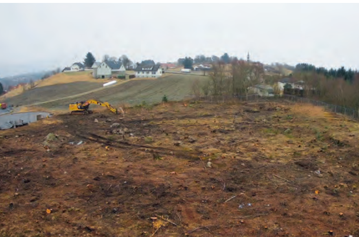
9. april, 2018: Tomten er avskoget og ryddet. Rigging av byggegjerdet pågår. Foto fra byggekamera
