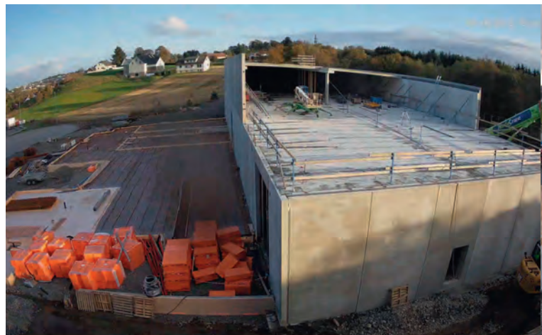
3. oktober, 2018: Elementmontasje i magasinindelen. Armering av gulv i verksted og servicedelen pågår. Foto fra byggekamera
