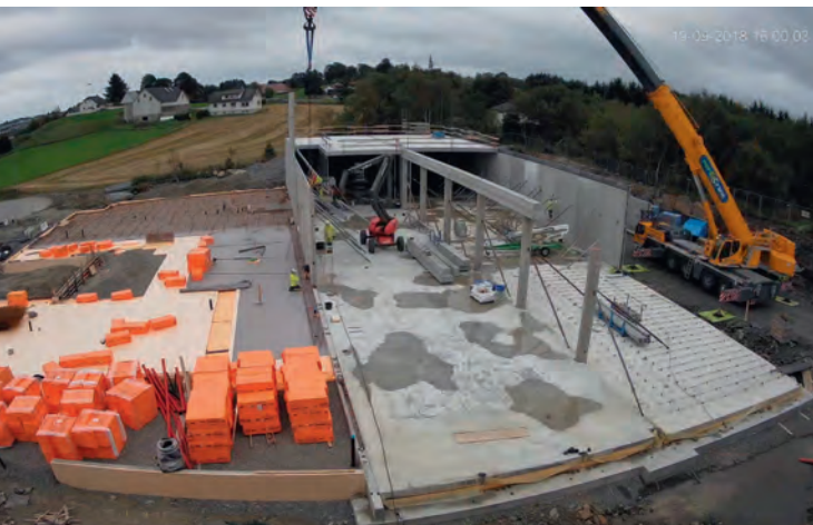
19. september, 2018: Montering av dekke- og fasadeelementer til magasinindelen. Isolering og armering av gulv i verksted og kontor pågår. Foto fra byggekamera
