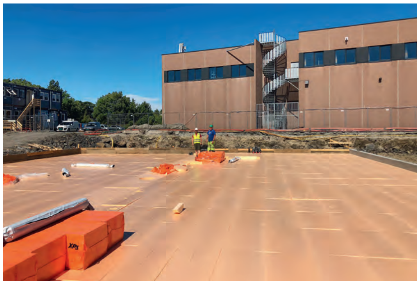
Isolering er ferdig utført, og det klargjøres for støping av gulvet i magasindelen. Foto: Arild Idsøe
