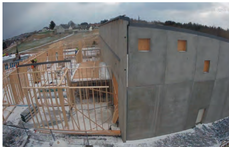
14. januar, 2019. Bygging av reisverk til fasade og innvendige vegger. Dekke i teknisk rom er ferdig montert. Foto fra byggekamera
