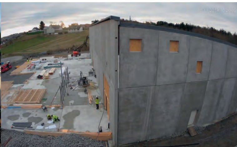
16. november, 2018. Magasindelen av bygget er tett og gulv er støpt i kontor- og servicedel. Reisverk i fasader er igangsatt. Foto fra byggekamera
