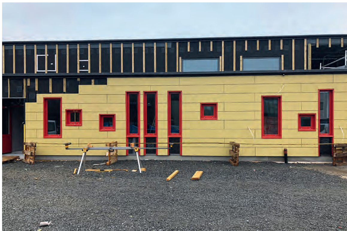
Fasadekledning av kontordelen med sementbaserte plater. Foto: Arild Idsøe
