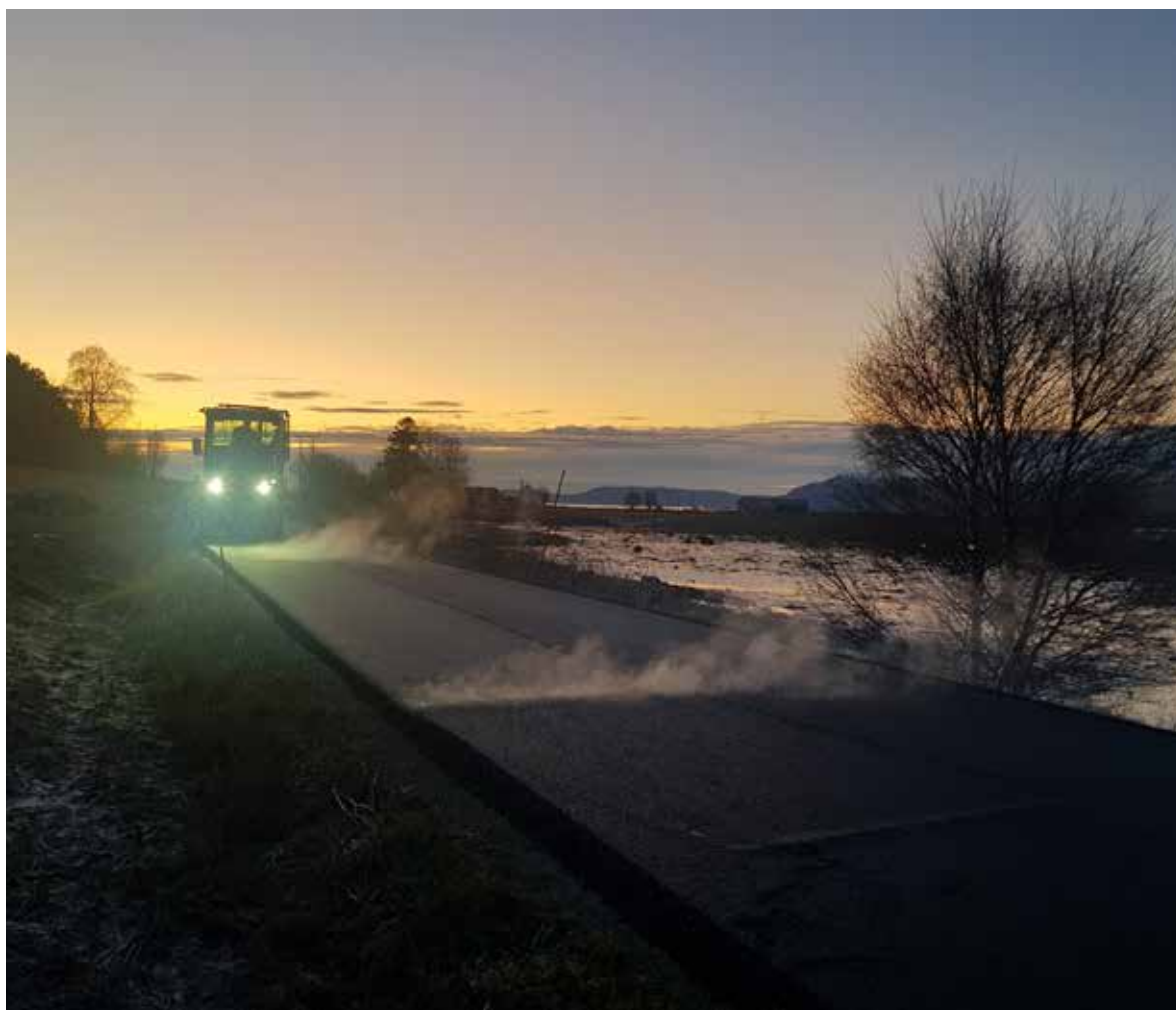
Høst og siste asfalten på plass. Foto: Linda Pettersen
