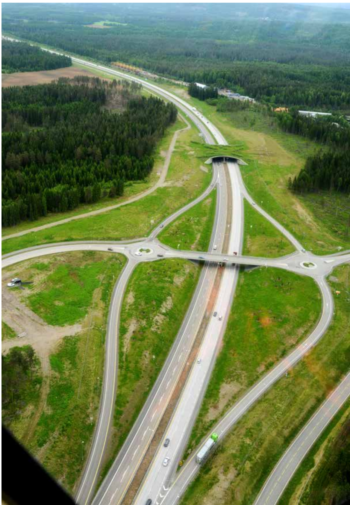
Utforming av motorveg. Foto: Knut Opeide
