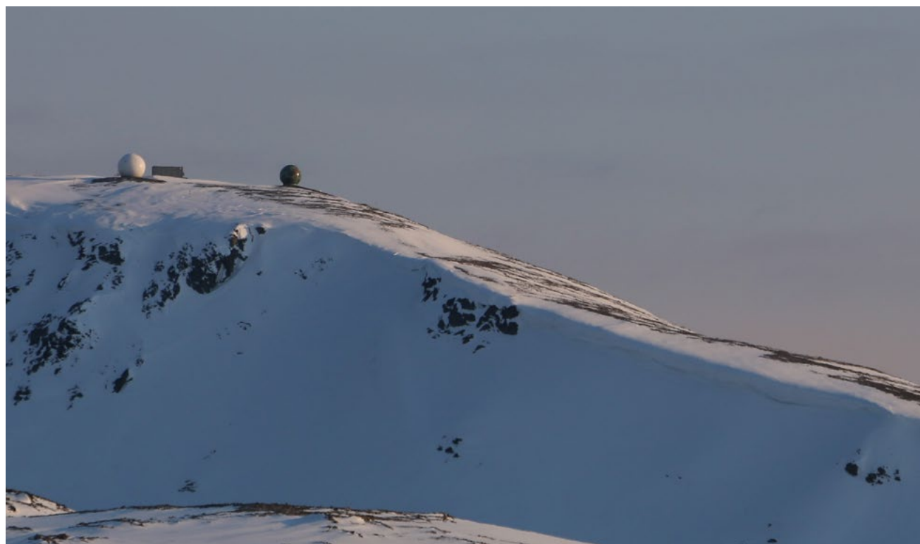
↑ Kystverkets antenner i Vardø. Antennene brukes til kommunikasjon med AIS-satellittene. Foto: Statsat.
