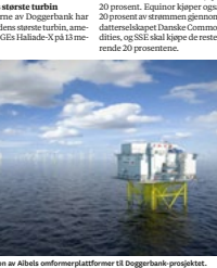
Illustrasjon av Aibelts omformerplattformer til Doggerbank-prosjektet.
