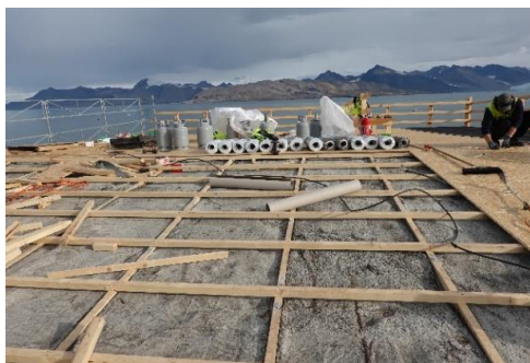
Takarbeider på Renseverket aug 2020. Foto Kings Bay
