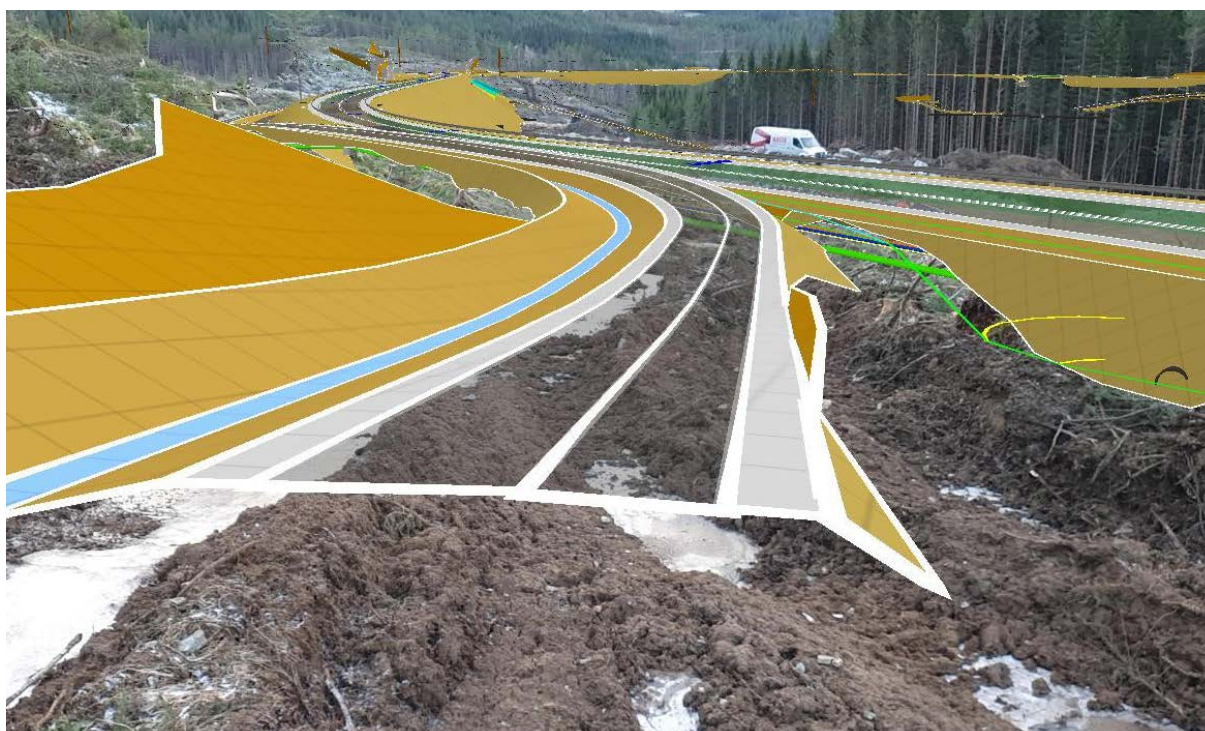
Bruk av Bygningsinformasjonsmodell (BIM) på E39 Betna-Stormyra. Foto: Line Sjøeng / Statens vegvesen
