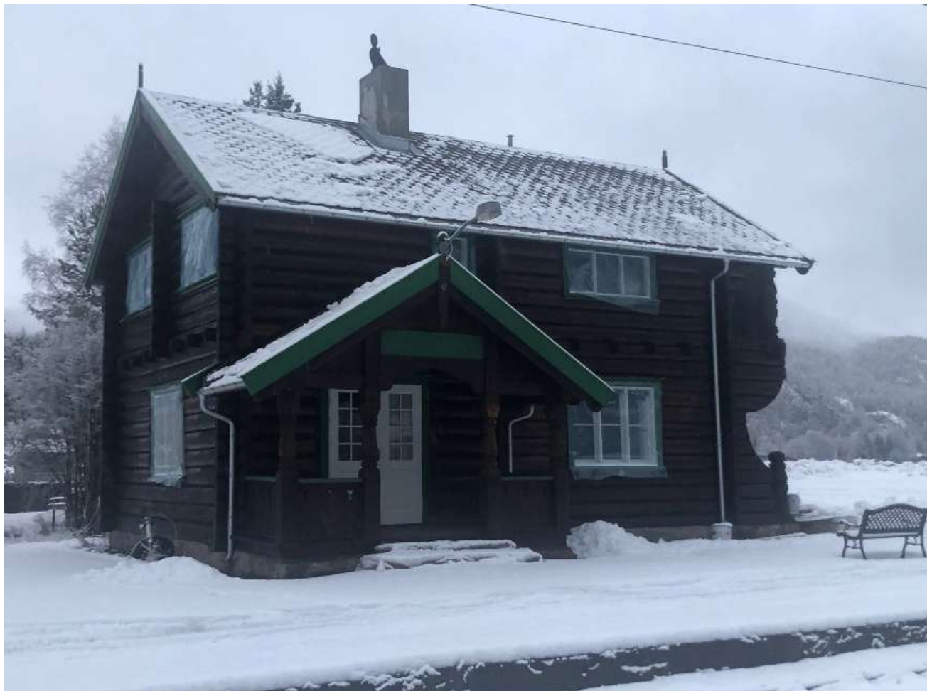
Tinnoset stasjonsbygning under istandsetting. Foto: Bane NOR Eiendom
