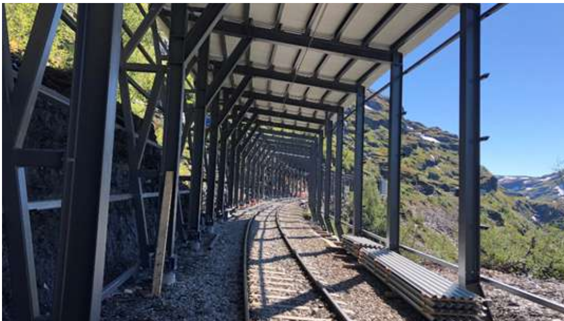
Snøoverbygget som i sommer ble gjenreist i en forsterket utgave i stål som bedre skal stå imot snøskred, samtidig som det hindrer at sporet blåser igjen med snø. Foto: Karl Morten Undal
