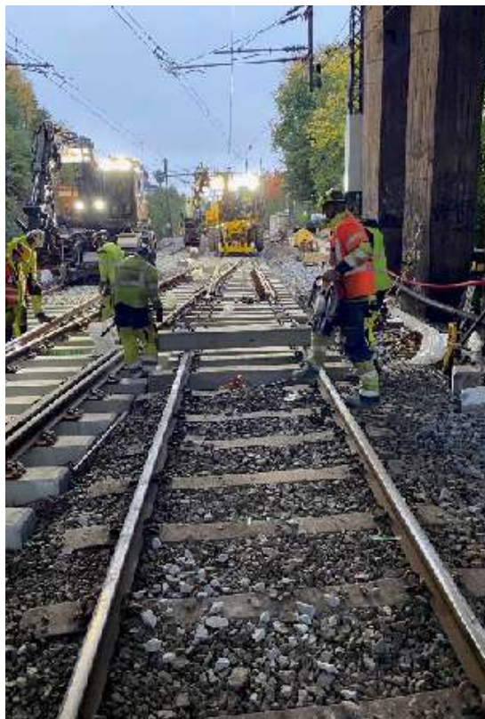
Arbeid i forbindelse med bytte av sporveksel på Bryn. Foto: Espen Reksten
