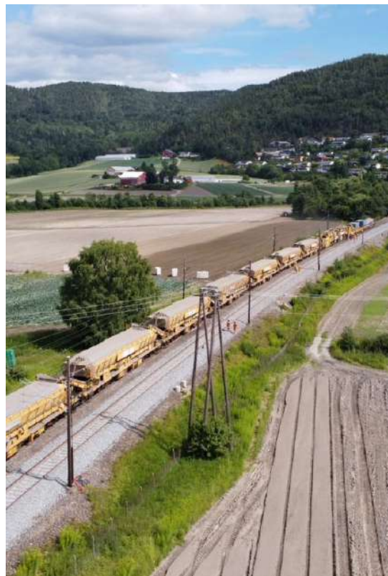
Ballastrensing mellom Lier og Brakerøya. Foto: Andreas Harreschou / Bane NOR
