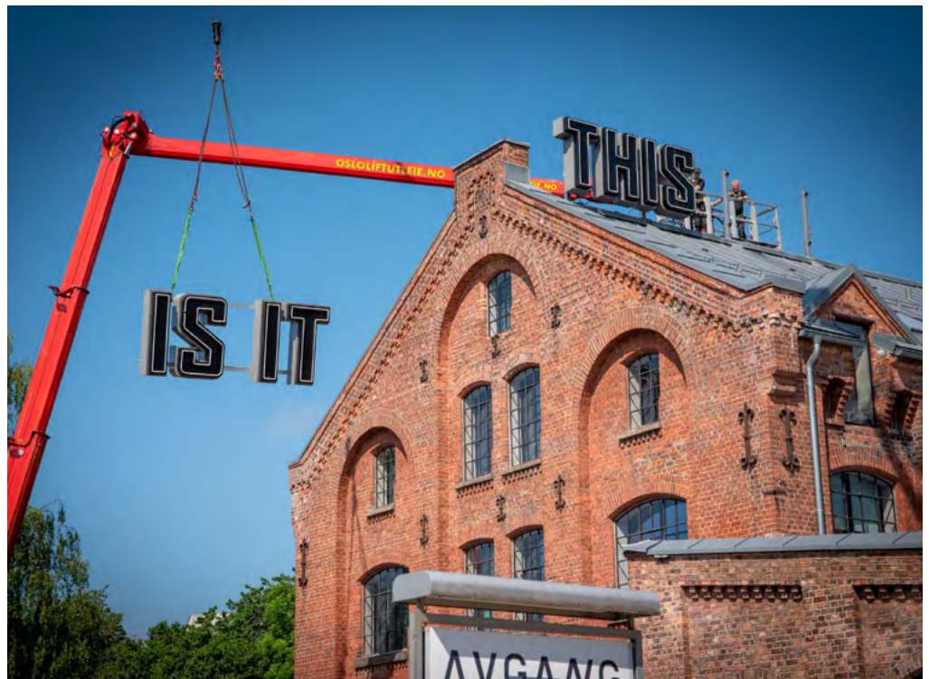
Demontering av kunstverket "THIS IS IT". Skolens gårdeier utføre sommeren 2021 nødvendige reparasjoner i takkonstruksjonen på den delen av bygningen der kunstverket "THIS IS IT" var installert. Foto: Jan Petter Hansen
