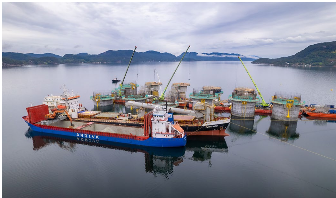
Glidestøp av betongfundamenter på Dommersnes i juli 2021, til Hywind Tampen flytende havvindpark.
