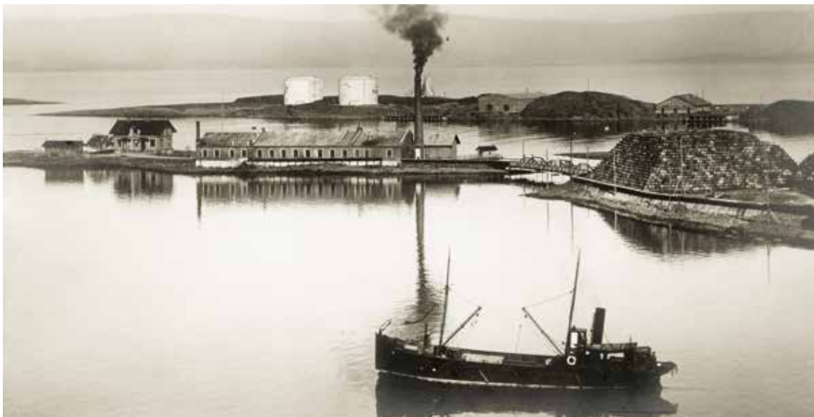
Landsteilene og Persteilene eid av ØPC og Storsteilene eid av Det norske Petroleumscagnie like bak, i 1898. DnPs nye tanker lyser opp. Ett av to tønnefjell til høyre i bildet. Bestyrerboligen, uthus og produksjonbygget i murstein med kraftig dampmaskin og pipe står fortsatt og brukes av Nesodden Kommune. «Petrolea» i forgrunnen. Foto: ExxonMobil sitt historiske arkiv/Norsk Olje og Gassarkiv
