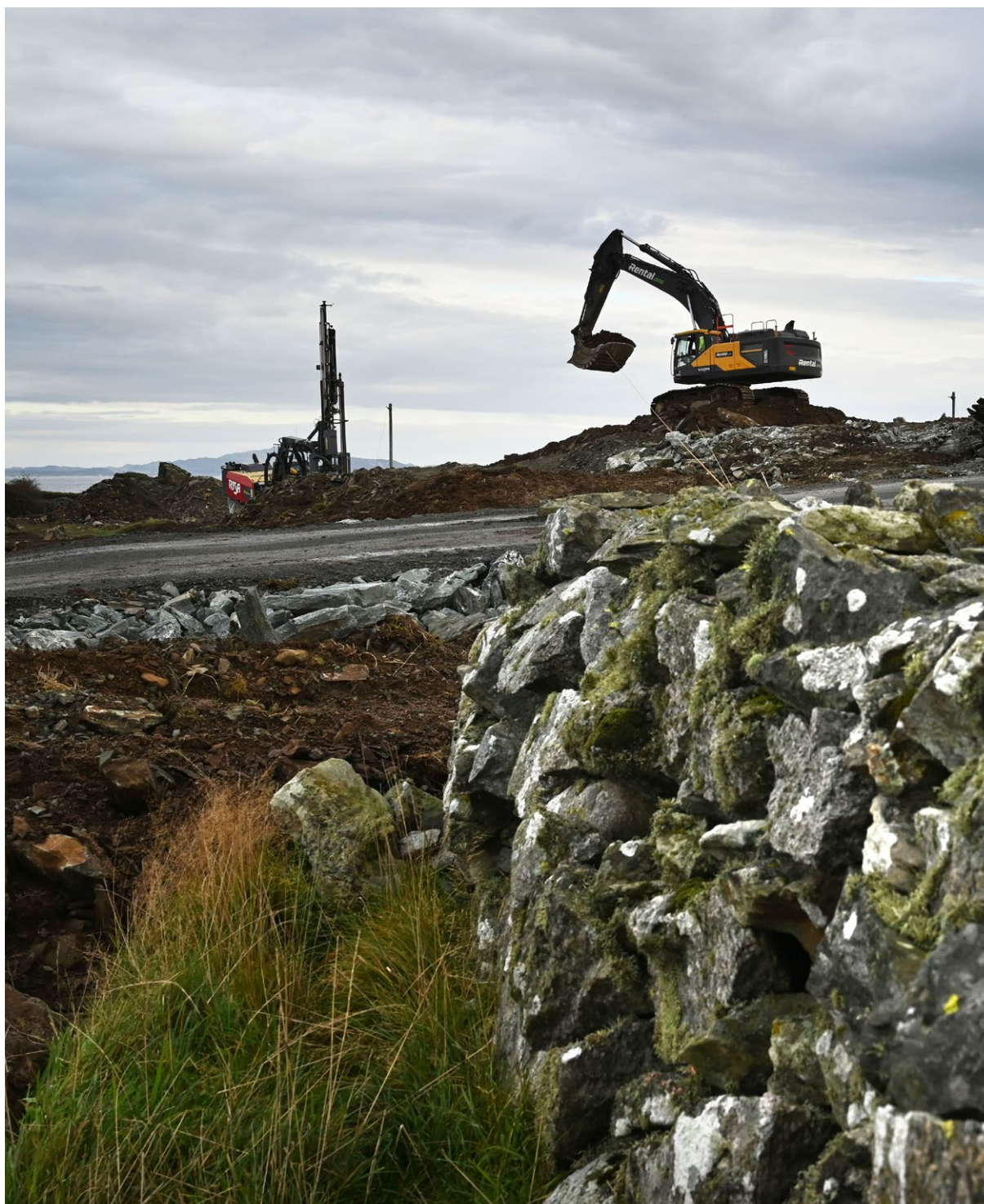
Byggeaktivitet på Kvitsøy som del av prosjektet E39 Rogfast. Foto: Øyvind Ellingsen / Statens vegvesen
