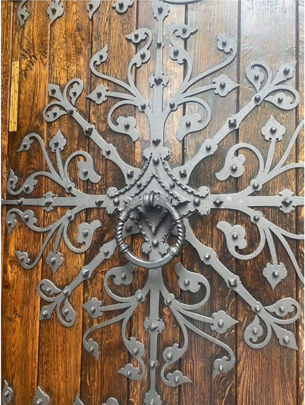
Dørene på Kongeinngangen er klare for bruk. Smijersornamentikken har over 1.000 håndsmidde skruer, ingen av dem er like.
