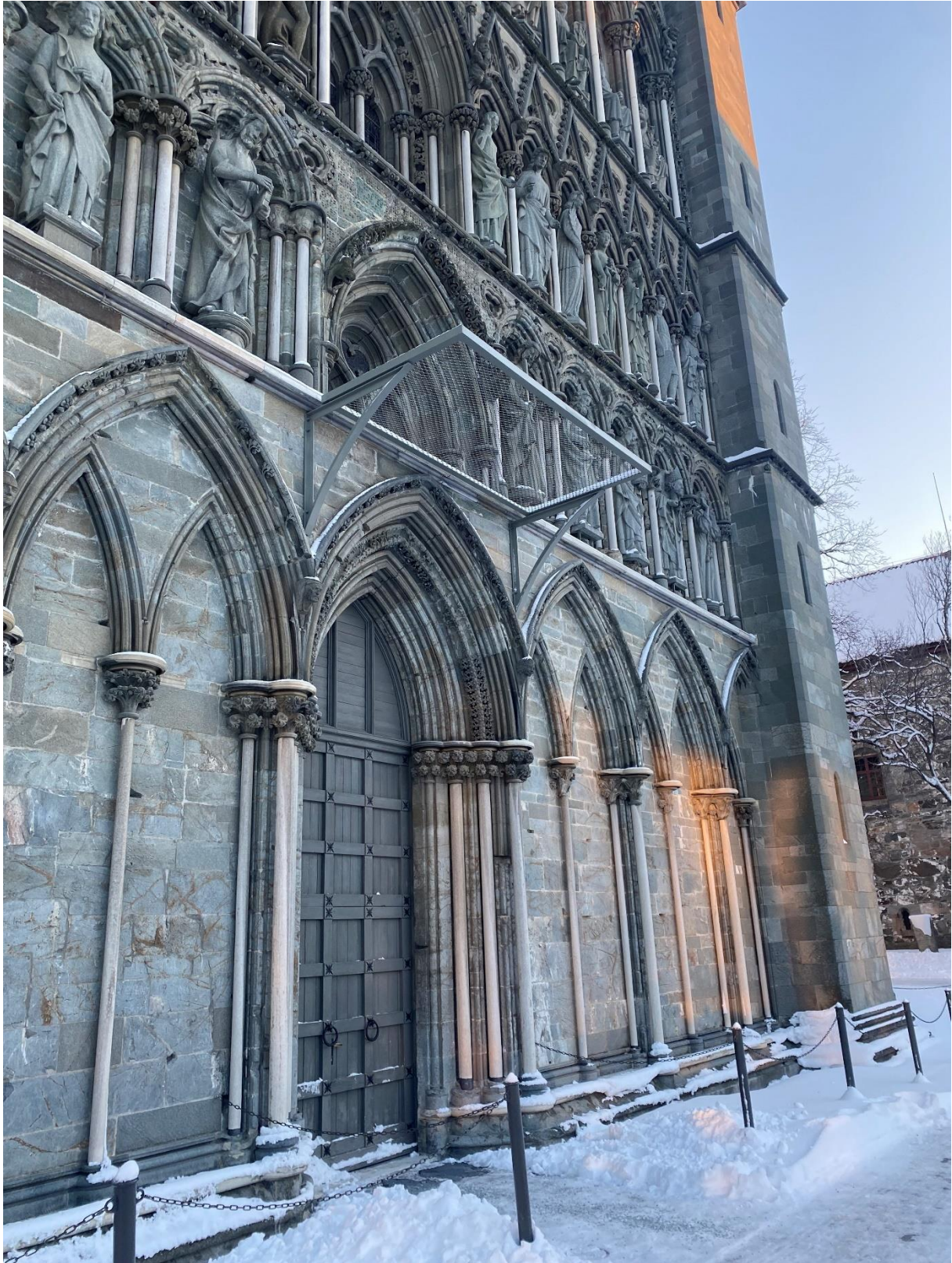
I 2022 har NDR ferdigstilt en baldakinløsning med nett over Nidarosdomens nordre og søndre portaler på Vestfronten, for sikring mot steinfall.
