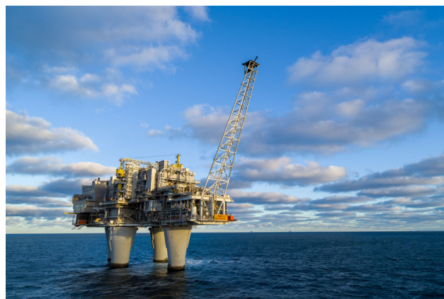
Troll A-plattformen etter installasjon av ny modul knyttet til Troll fase III i 2020. Troll er et av feltene som årlig søker myndighetene om særskilt produksjonstillatelse for gass. Foto: Øyvind Gravås / Even Kleppa / @ Equinor
