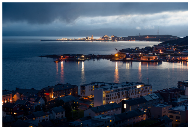
Equinors LNG-anlegg på Melkøya ved Hammerfest Foto: Ole Jørgen Bratland / @ Equinor
