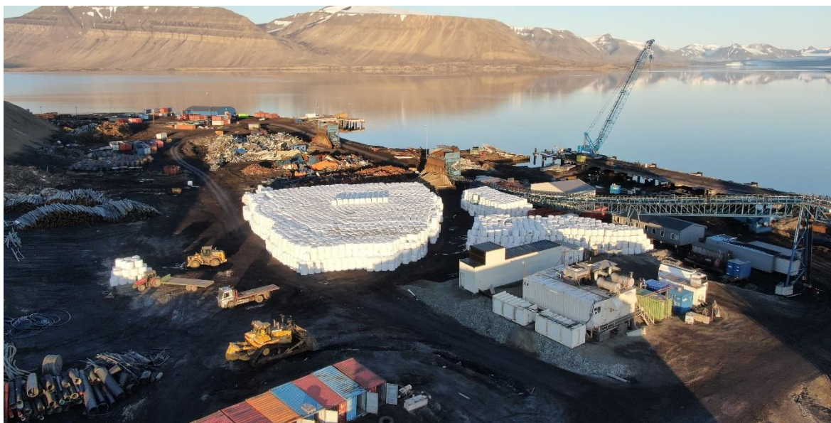
Avfall fra opprydningen i Svea, sortert og klargjort for utskipning.
