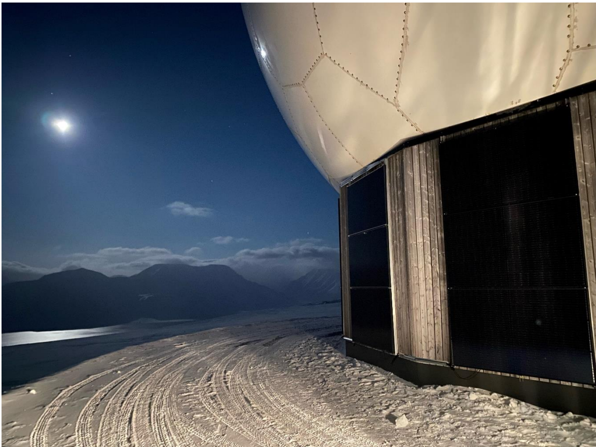
Satellittkommunikasjon på Svalbard skal få strøm fra solceller. Foto: Store Norske
