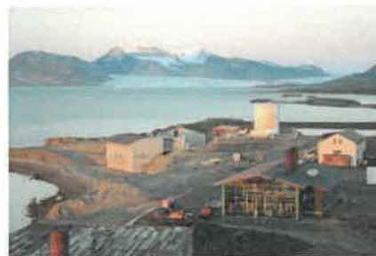
Kraftstasjon og tankanlegget. Foto: Linda Bakken
