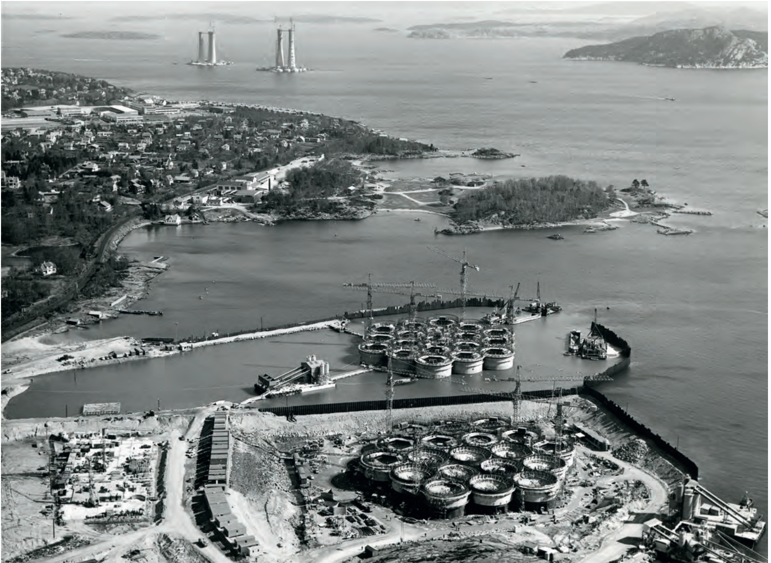
Flytende i dokken er betongunderstellet til Statfjord A og i tørrdokk ser vi Brent D, bak skimtes Brent B (til venstre) og Beryl A. Foto: Norsk Fly og Flyfoto A/S / Norsk Oljemuseum
