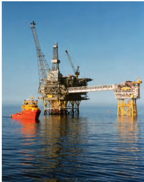
Ei stigerørsplattform (HRP) blei lagt til for at Heimdal skulle kunne vere gassenter. Foto: Vegar Stokset/Norsk Hydro ASA
