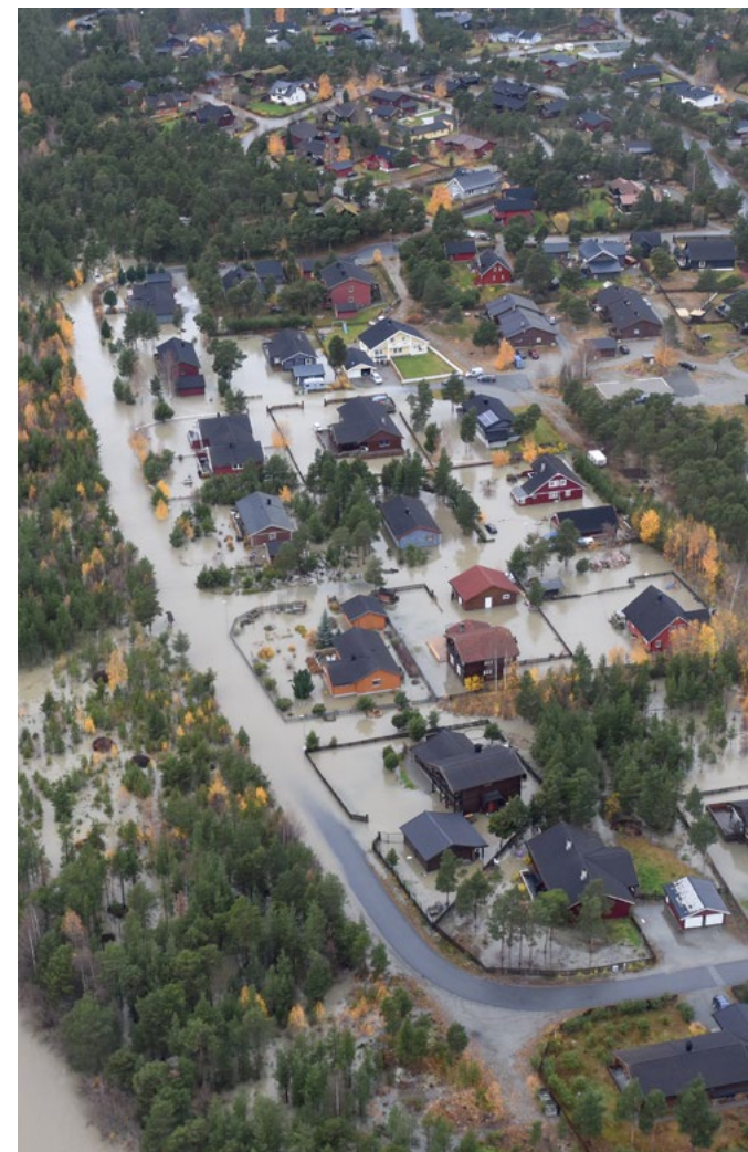
Skade grunnet flom utgjør 70 prosent av erstatningssummen innen naturskader.
