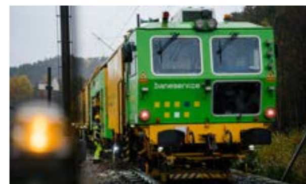
I august signerer Baneservice en ny sporjusteringskontrakt for område Nord.
