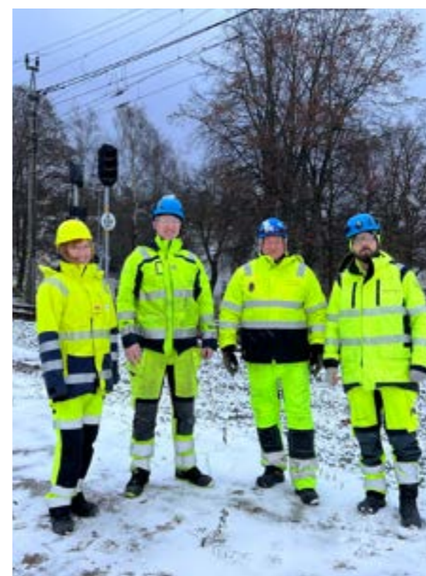
Baneservice er ansvarlige for signalarbeidene ved Sandefjord Stasjon.
