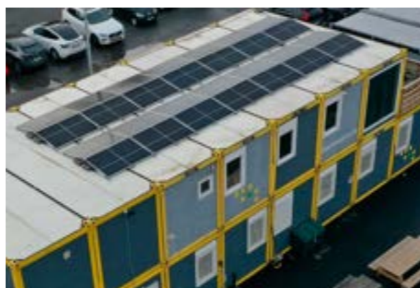
Kontorriggen i Drammen er delvis drevet av solceller.
