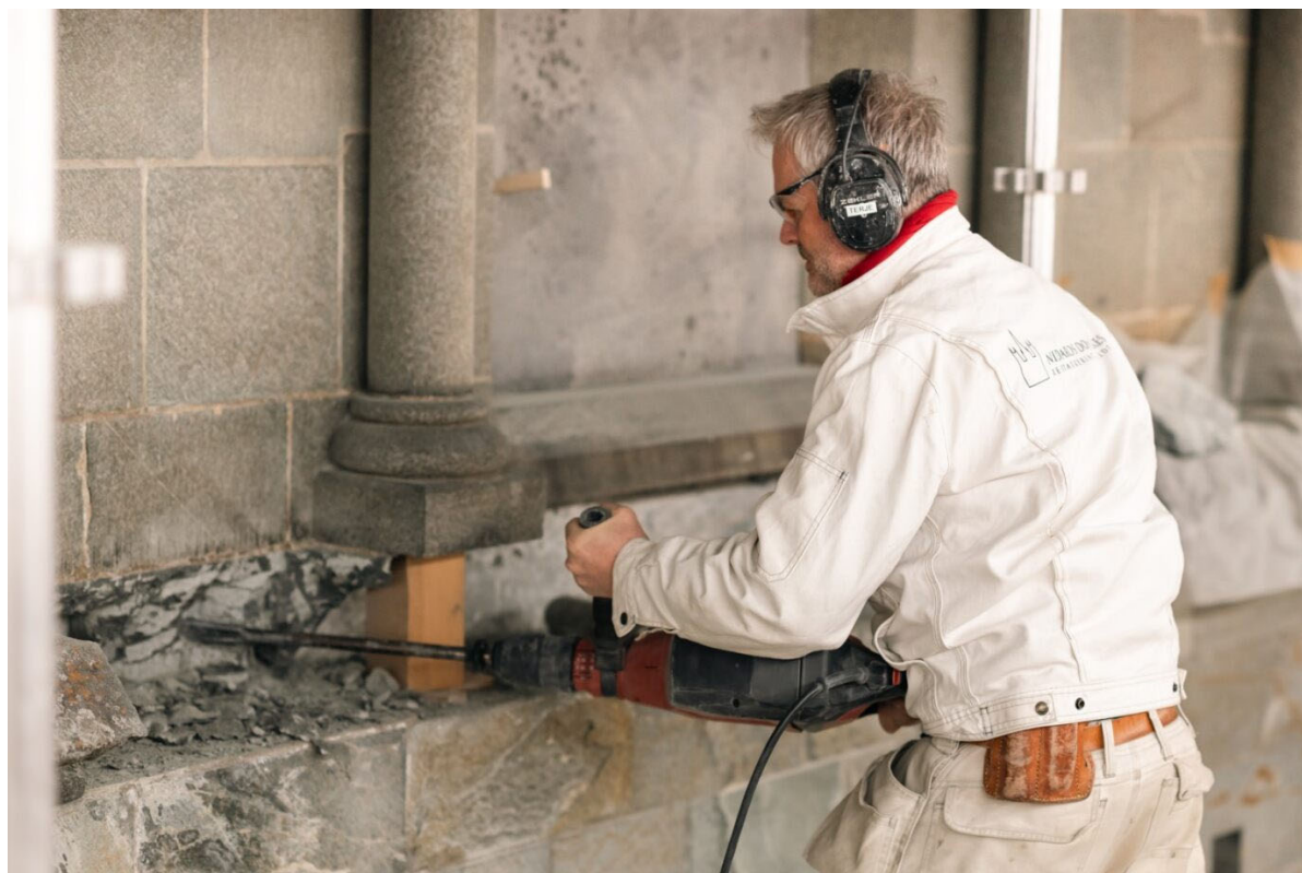
Murer Terje Gimnes på stillaset på Sørgavlen. Foto: Ina Stenvig
