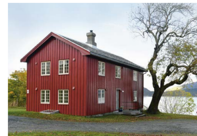
Borgstua på Kvernes prestegård er rehabilitert av OVF og blir sammen med presteboligen overført til Den norske kirke.
