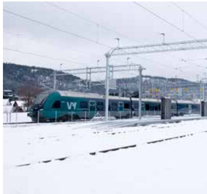
Med ny togparkering på Kongsberg slipper togene å kjøre tomme helt tilbake til Drammen for å parkere for natten.
