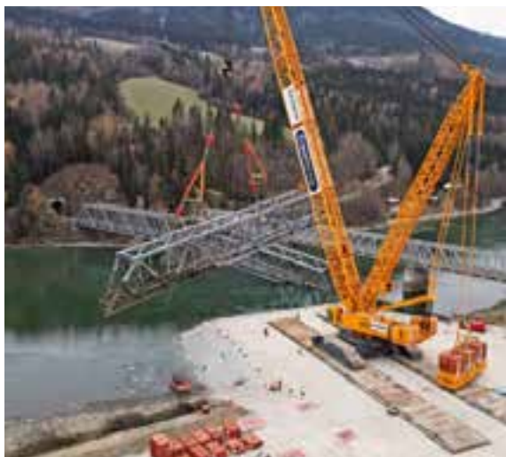
I oktober ble broelementene til Randklev bru hevet opp fra Gudbrandsdalslågen. Broelementene var i god nok stand til å gjenbrukes, og broen gjenåpner til sommeren 2024.
