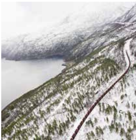
Det transporteres årlig mer enn 15 millioner tonn gods på Ofofbanen. Målt i antall tonn er det mer enn all annen godstrafikk med jernbane i Norge til sammen. Malmtransporten fra Kiruna står for en stor del av dette.
