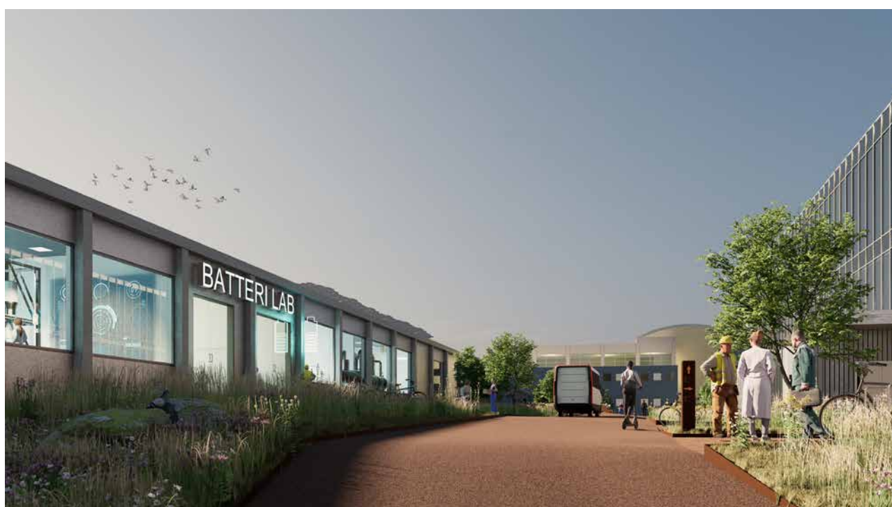
IFE har innført tiltak for energieffektivisering og reduserte klimagassutslipp fra drift i 2023.
