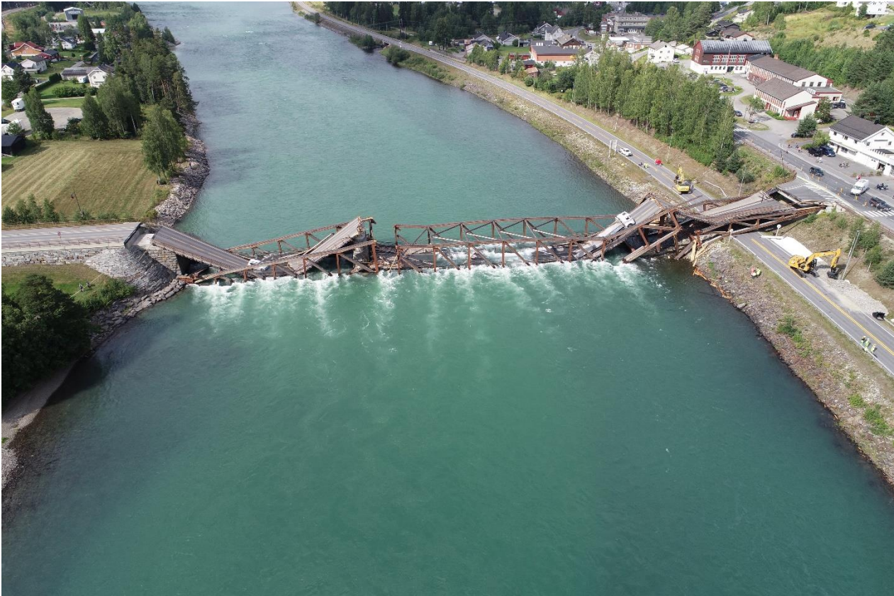
Tretten bru med to kjøretøy på brua etter kollapsen, sett fra sør. Foto: SHK
