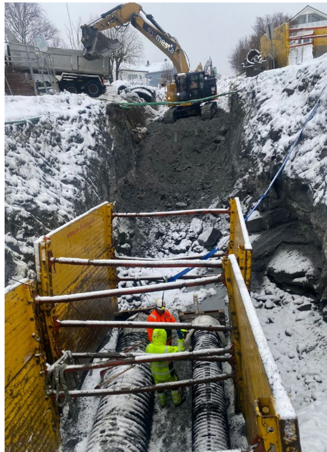
Mesta ferdigstilte i slutten av 2023 det første prosjektet med gjenbruk av betong. I Hernesveien i Bodø, ble betong knust og gjenbrukt som fyllmasse i grøftene. Det resulterte i mindre massetransport, penger spart og reduserte CO2-utslipp.
