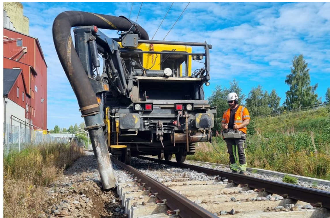
Arbeid med utbedring av skader i forbindelse med ekstremværet Hans.
