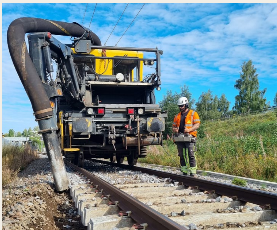
Arbeid med utbedring av skader i forbindelse med ekstremværet Hans.
